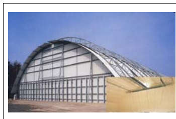
Graansilo EEG gasdicht gespoten
